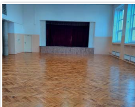
Rekonstrukce podlahy v tělocvičně
